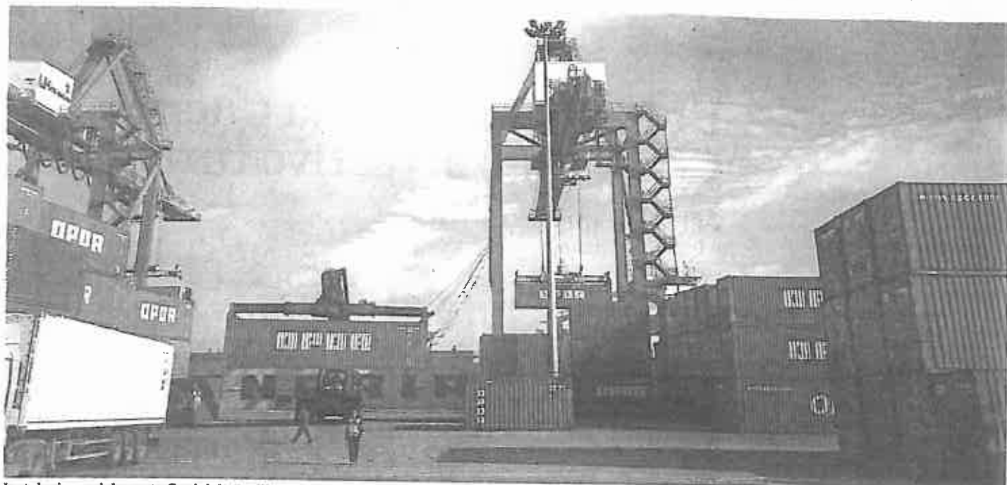
Instalaciones del puerto fluvial de Sevilla, situado a orillas del río Guadalquivir
