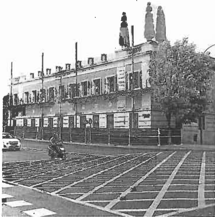
El edificio de la Aduana durante las obras de reforma
