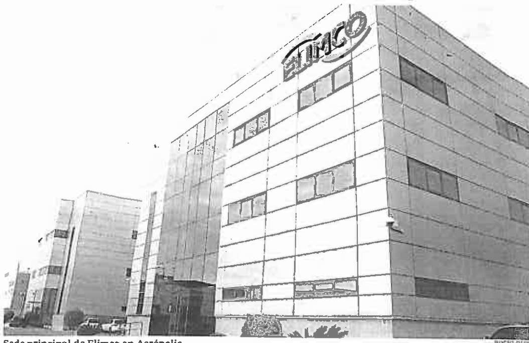
Sede principal de Elimco en Aerópolis
