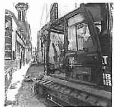
Obras de repavimentación. / José Luis Moya
