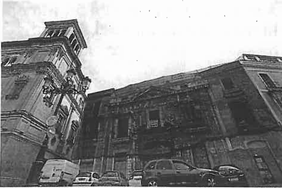
Fachada de la Casa de la Moneda, cuyas obras quedaron paralizadas en enero de 2011
