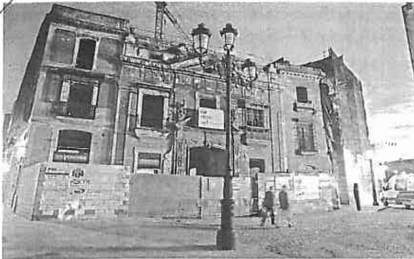
La Delegación Provincial de Cultura paralizó las obras de rehabilitación en febrero de 2011. / El Correo
