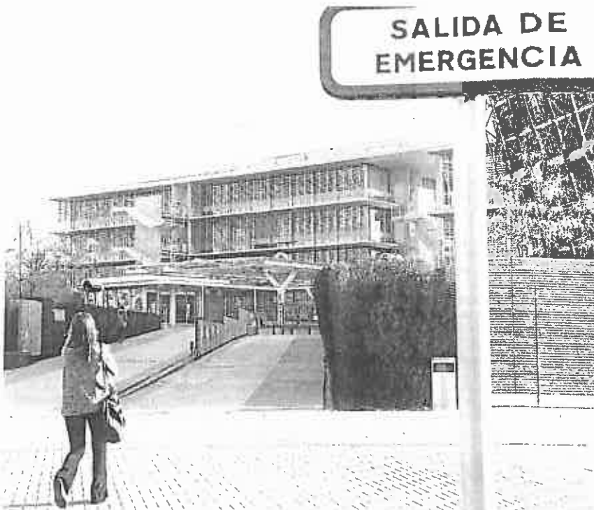
Instalaciones de la multinacional Abengoa en Palmas Altas, en Sevilla. / José Luis Montero
